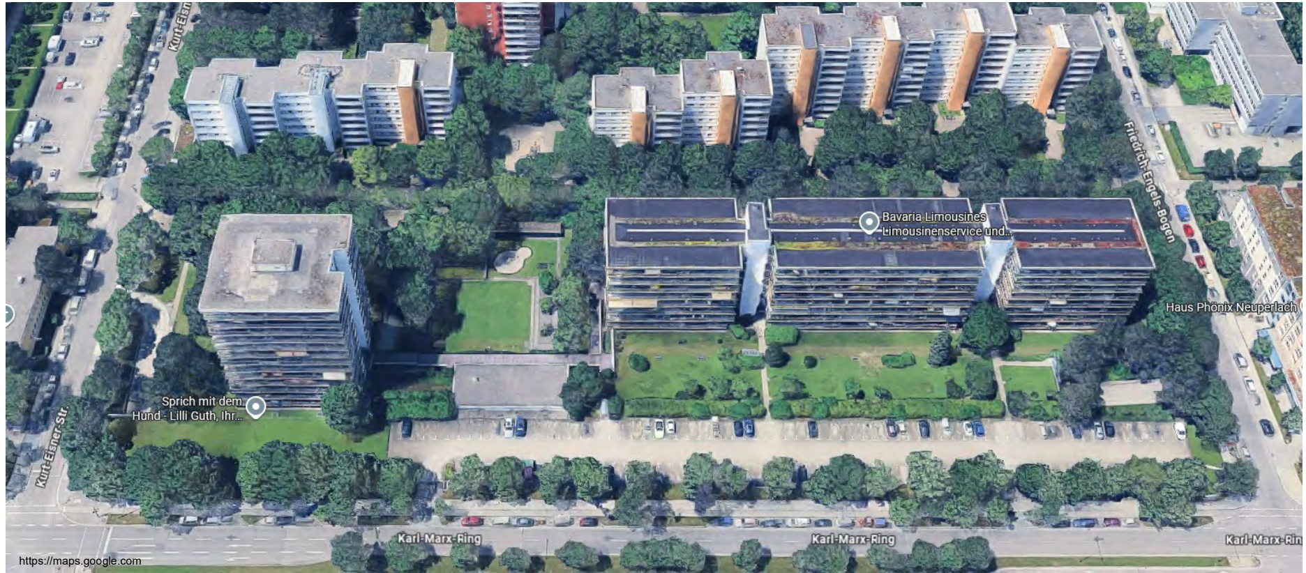
1972: Wohnanlage Friedrich Engels-Bogen 3-5, Kurt-Eisner-Straße 41, Mü-Neuperlach Landschaftsarchitekten: Gottfried und Anton Hansjakob, Bauträger: EWO
