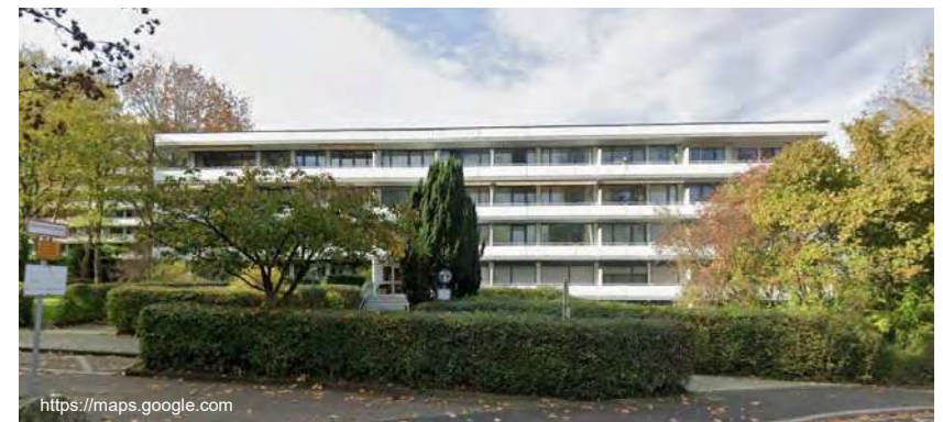
1975: Wohnanlage Muffendorfer Str., Bonn Bad-Godesberg Landschaftsarchitekt: Peter Leitzmann, Bauträger: Münchner Grund
